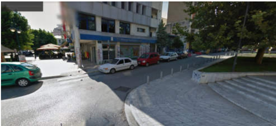
Εικόνα 3.3: Ασυνέχεια στο διάδρομο κίνησης πεζών μεταξύ πλατείας Ειρήνης και Δημάδη, λόγω ελλιπούς διαμόρφωσης διάβασης πεζών
