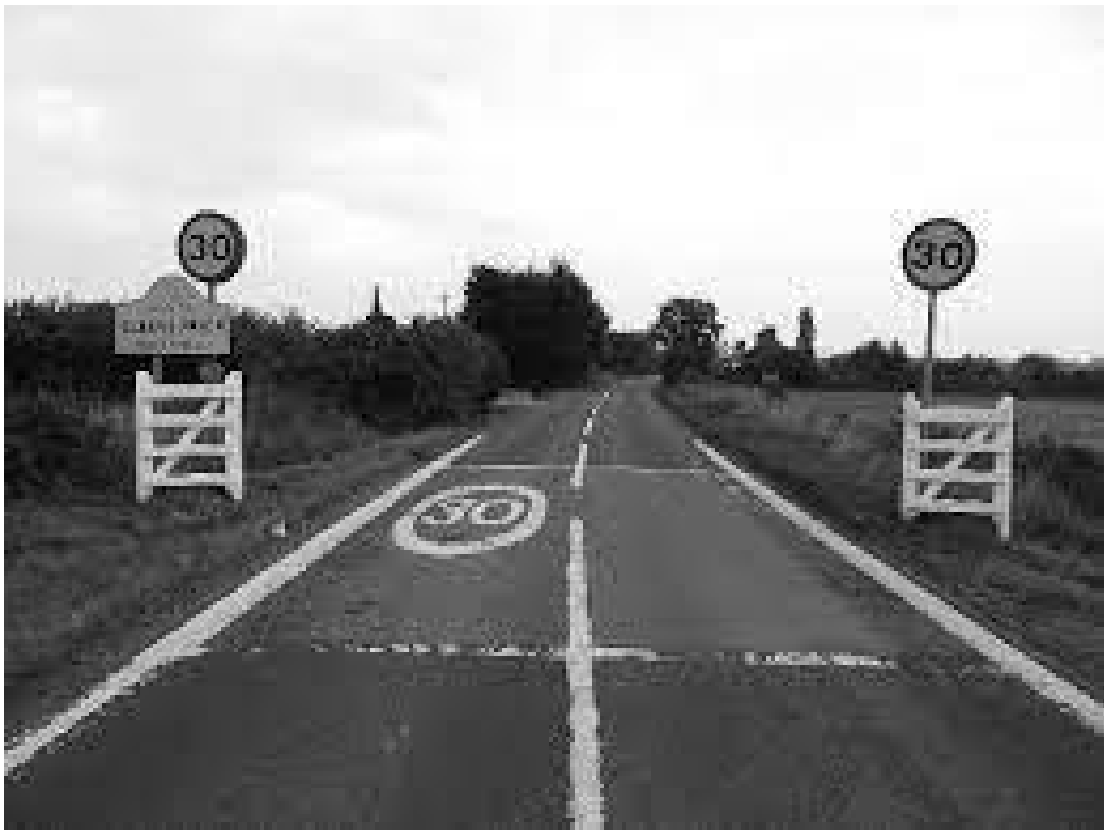
Εικόνα 5.4: Παράδειγμα παρέμβασης οδικής ασφάλειας σε σημεία εισόδου σε οικιστικές ζώνες
